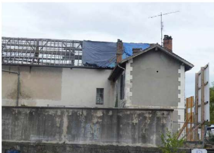
En face de la gare, les travaux de démolition ont démarré. Le choix a été fait de récupérer les matériaux « réemployables ».
