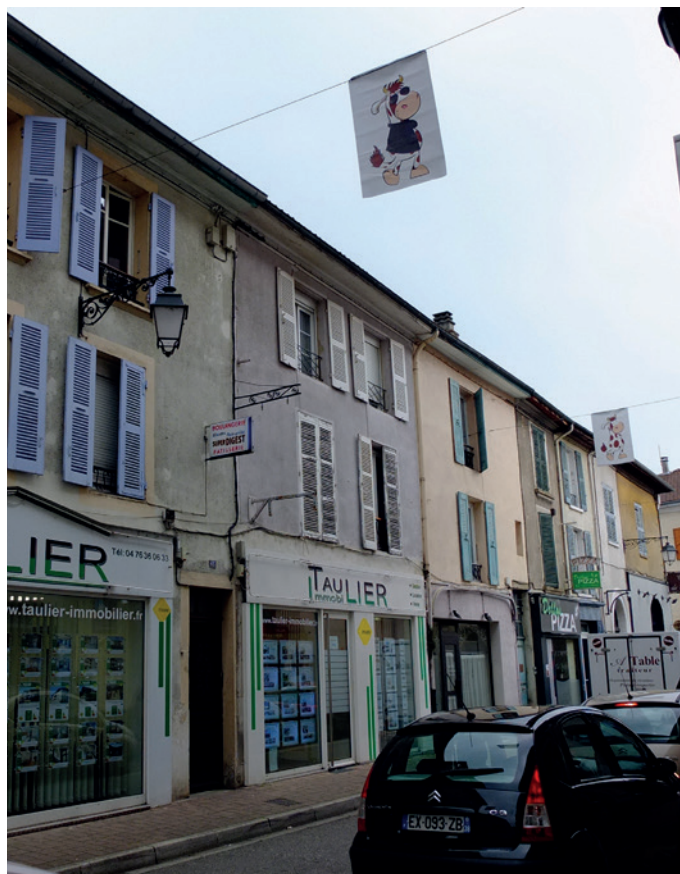
61 à 67 Grande Rue - Ancienne aile du couvent subdivisée en maisons de ville
