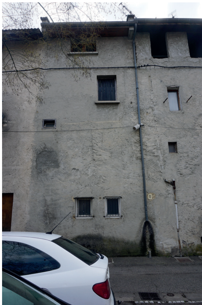
Façade arrière sur rue des remparts
