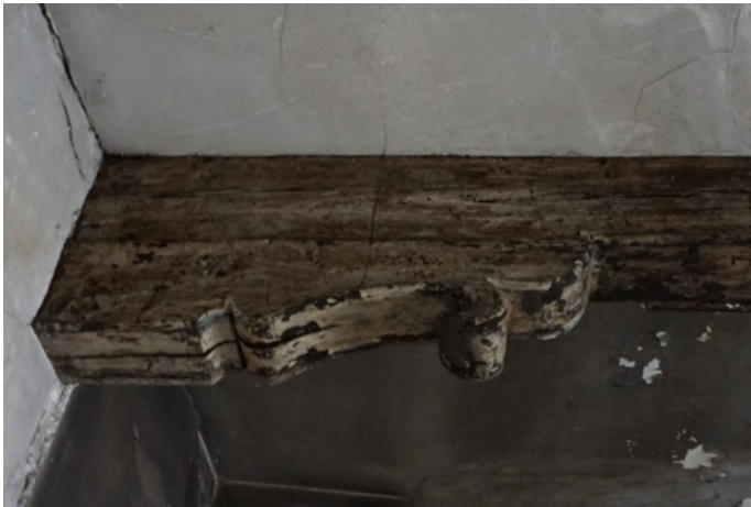
44 Grande Rue - Intérieur du premier niveau Plancher médiéval - Décors peints probables
