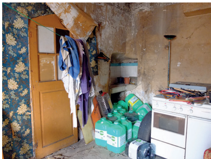
Cuisine créée dans une niche percée dans l'épaisseur du rempart au premier niveau
