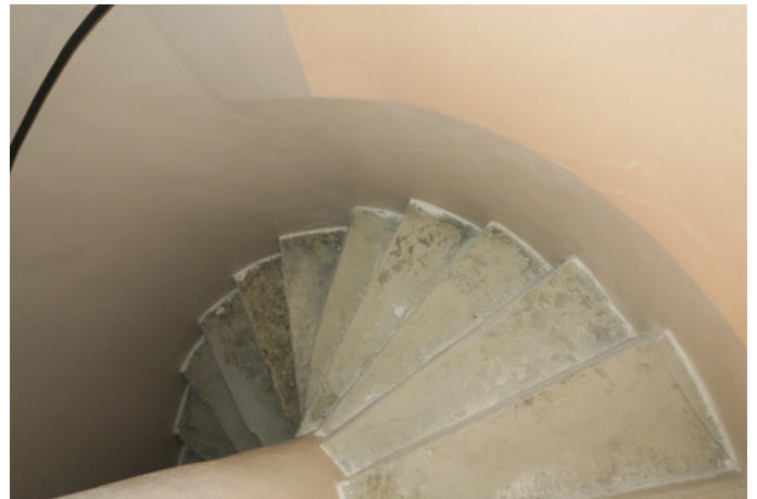
5 rue de la République - Escalier demi-circulaire
