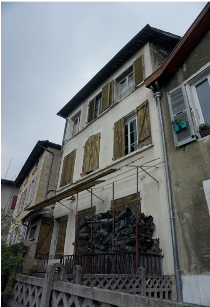
Façade arrière sur la route départementale
