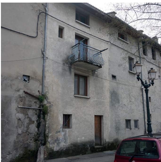
Façade arrière du 36 boulevard Gambetta. Le mur de façade est un mur fin, construit pour fermer l'ancienne gorge de tour. Pour cette raison, cette maison est la seule à posséder un balcon et des ouvertures généreuses.
