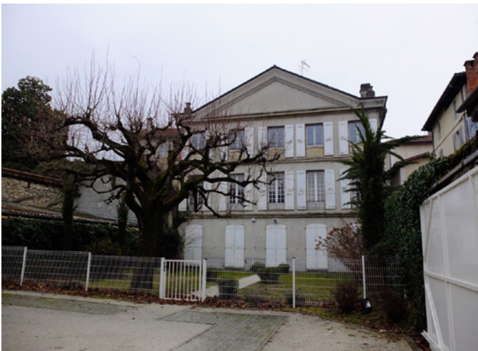
2 rue de Garagnol - Façade principale sur jardin
