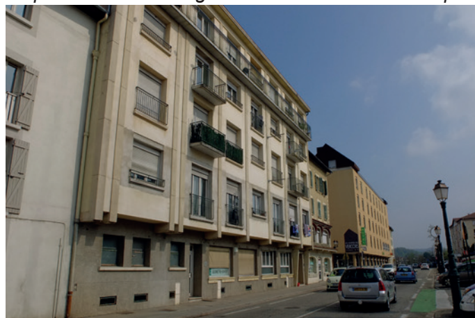
Façade avant du 22 boulevard Gambetta, édifice reconstruit après démolition de maisons de rempart
