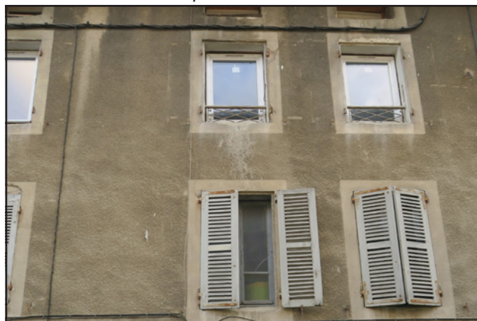
Volets persiennés et garde-corps ferronnés
