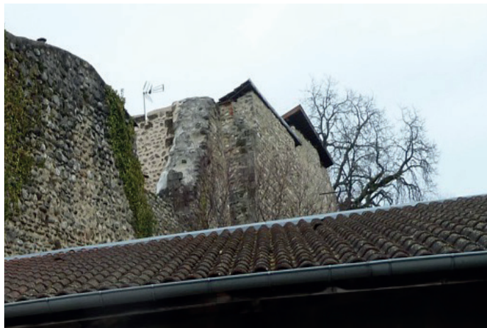
Tour visible à l'arrière du château sur la montée du coteau de Joud
