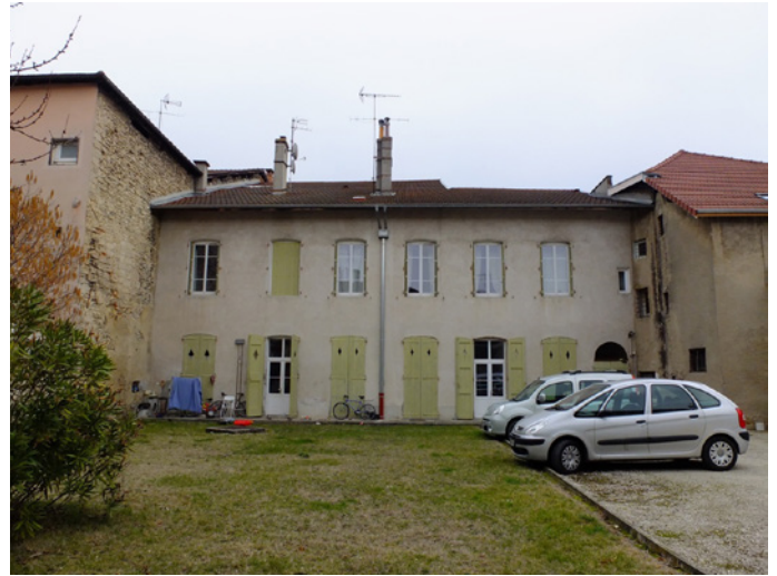
17 place d'Armes - Façade sur cour - Extension du bâtiment initial vers la cour, perte d'un niveau par prolongement du pan de toiture
