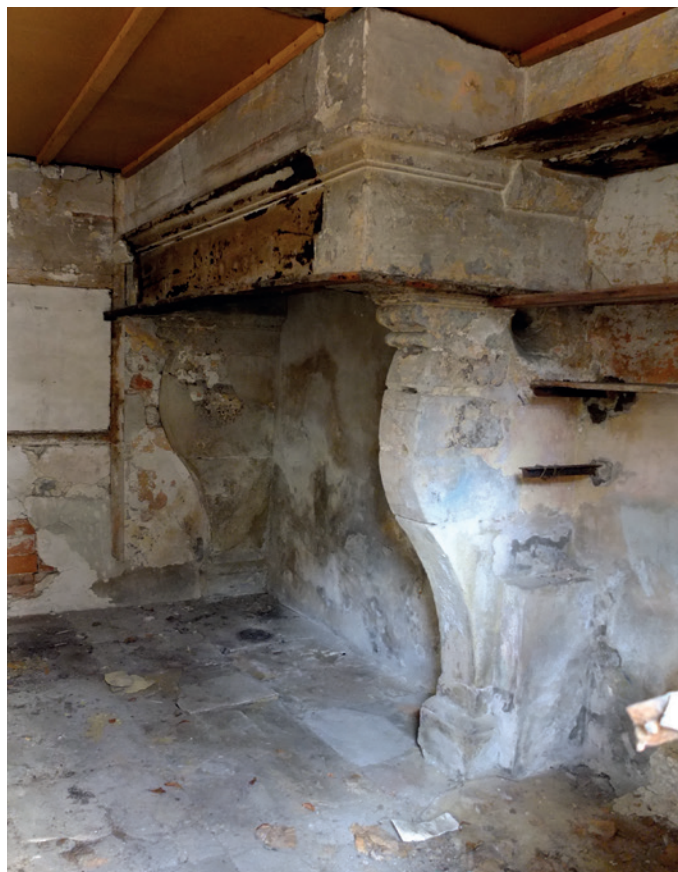
27 Grande Rue - Cheminée monumentale dans bâti en fond de cour
