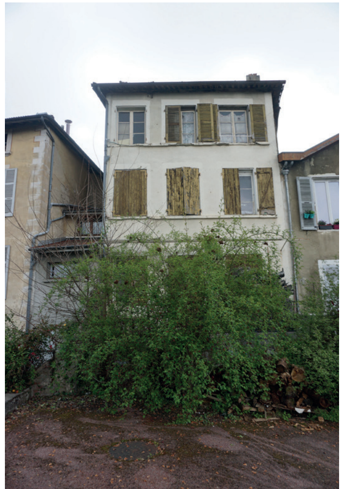
Façade arrière sur la route départementale
