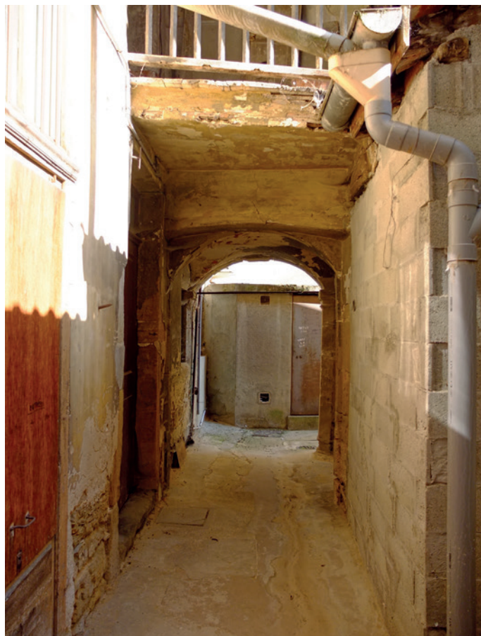
Passage sous porche
