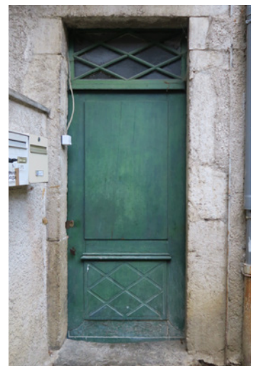
36 rue du Faubourg Vinay - Porte dans la ruelle haute
