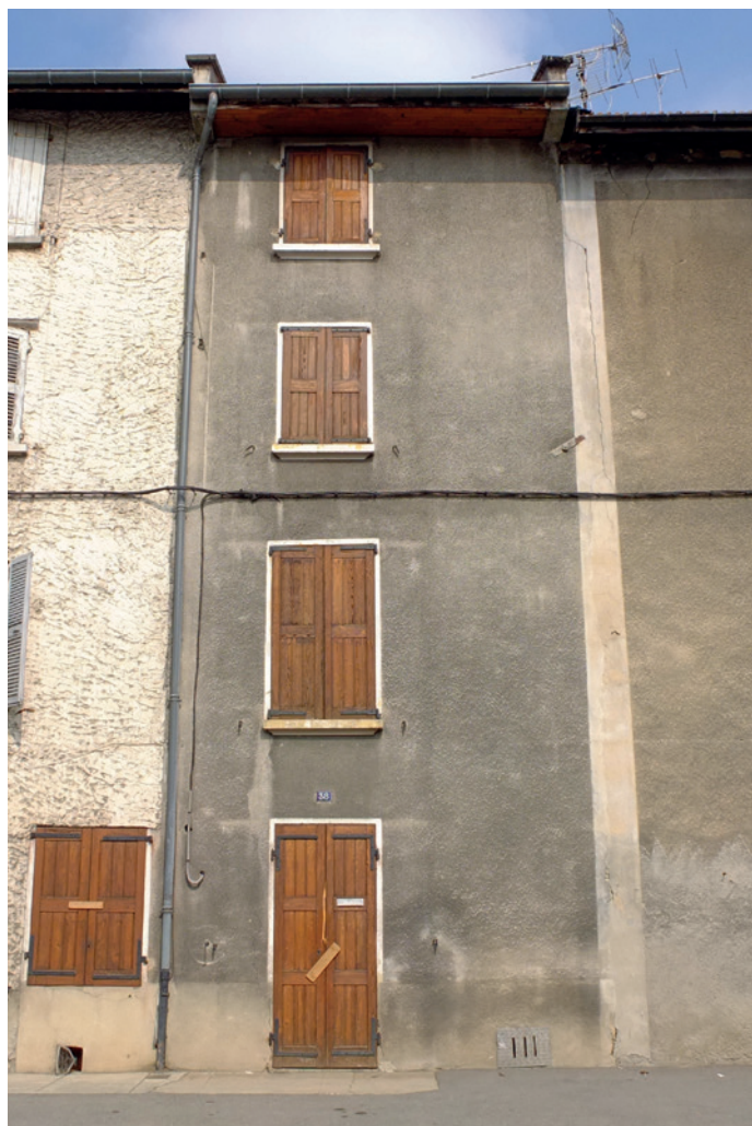
Façade principale sur boulevard
