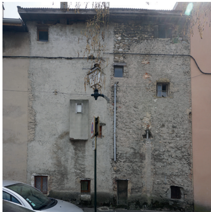
Façade arrière sur rue des remparts
