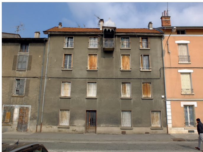
Façade principale régulière, enduit ciment, le balcon constitue le seul élément ornemental
