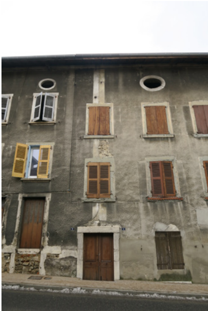
1-3 rue de la République - Façade sur rue avec décor
