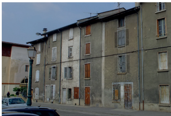
Ensemble de maisons de rempart de la fin du XVIII e siècle surélevées au XIX e siècle, bd Gambetta
