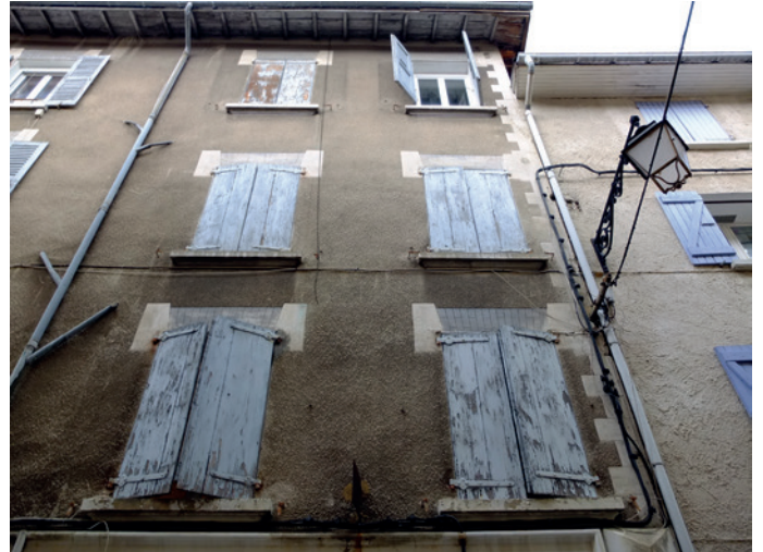
11 rue de France - Deux travées. Fenêtres avec persiennes à planches jointives XIX e ou XX e s.
