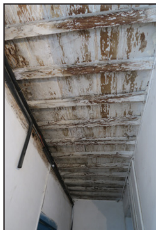
Couloir 1 er étage
