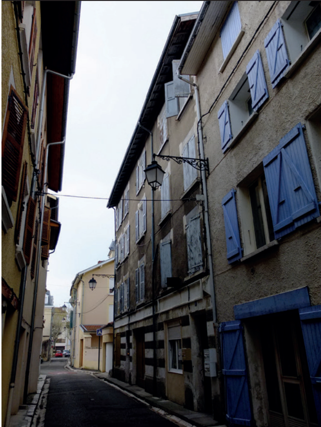
9-11 rue de France - Elévation sur rue depuis le Nord
