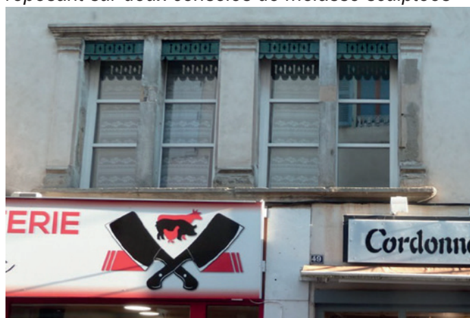
49 Grande Rue - Encadrements de baies du XVI e siècle conservés au premier niveau
