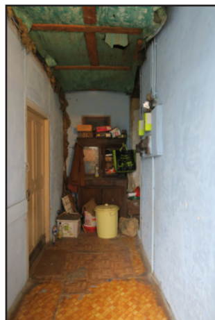
Couloir 2 e étage
