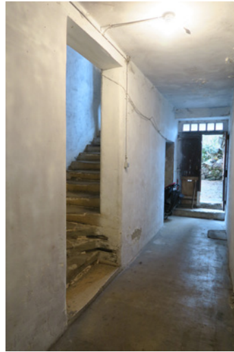
1-3 rue de la République - Escalier droit double quart-tournant
