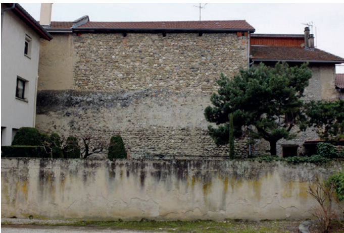
Portion de mur à l'arrière du 17 place d'Armes relativement homogène malgré une surélévation
