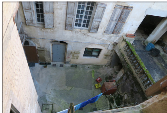
Cour (présence de 3 arcades en RDC)
