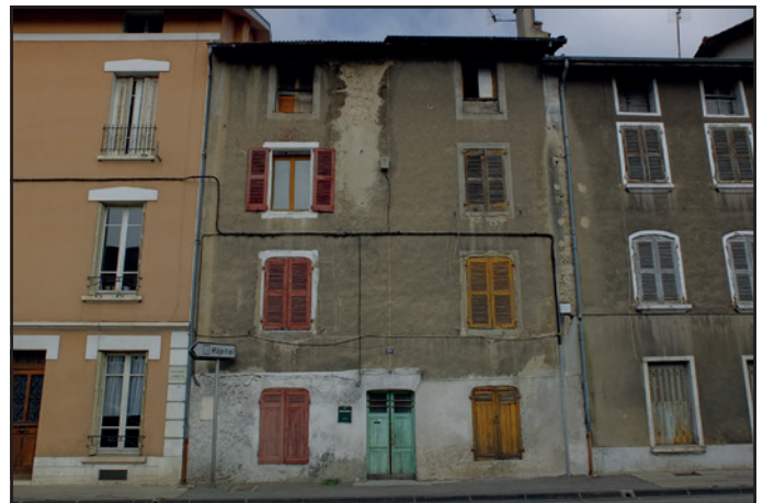
30 boulevard Gambetta - Vue générale
