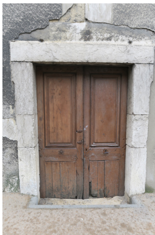
1-3 rue de la République - Porte d'entrée XVIII e s.
