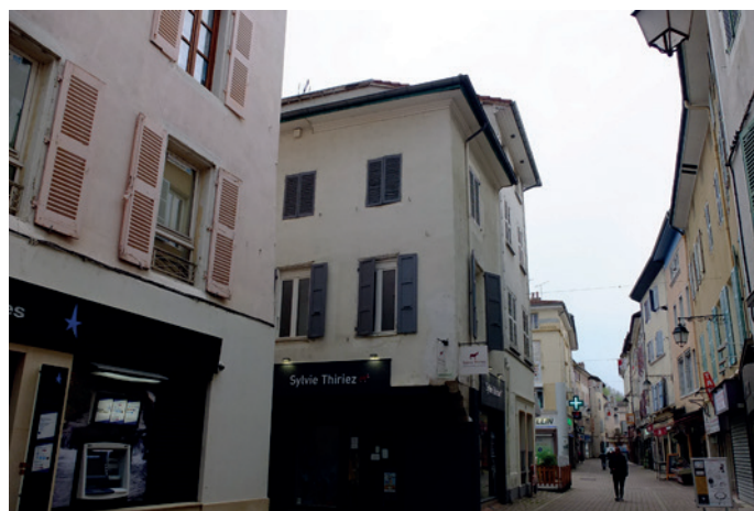
30 Grande Rue - Façade à pans de bois
