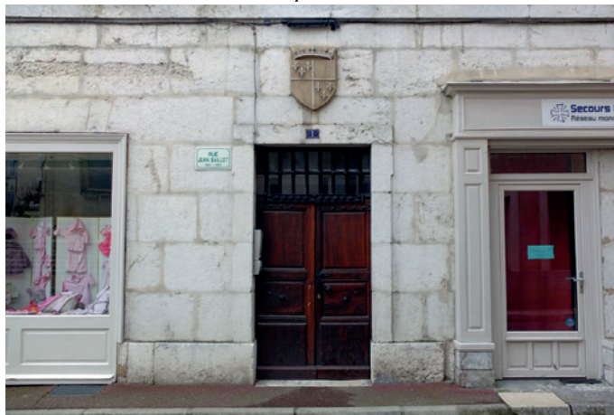
1 rue Jean Baillet - Façade en pierre de taille, encadrement saillant et blason (ancien tribunal)
