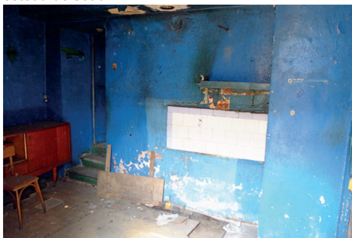
Intérieur du 36 boulevard Gambetta, l'ancienne tour sert de refend intérieur et comporte des vestiges
