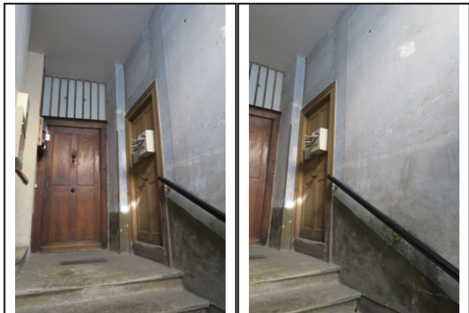
Montée d'escalier du 2 montée du Calvaire
