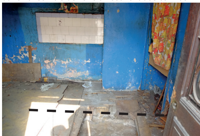
Intérieur du 36 boulevard Gambetta, l'épaisseur de l'ancienne tour est mesurable au sous-sol (1,60m)
