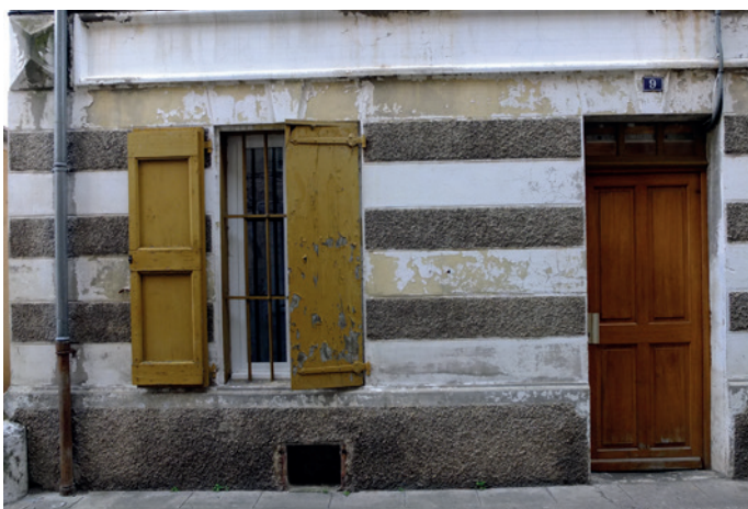
9 rue de France - Bossage du rez-de-chaussée sur rue
