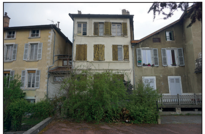
29 faubourg Vinay - Vue générale
