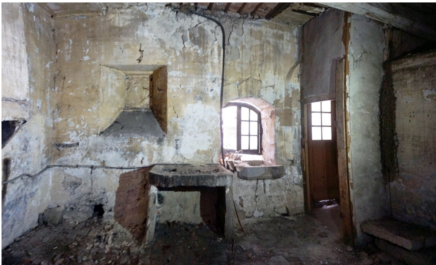
44 Grande Rue - Cuisine au premier niveau
