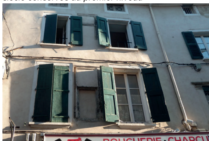
47 Grande Rue - Façade du XV e siècle conservée, modification des percements au XIX e siècle
