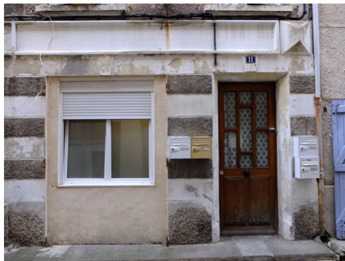
11 rue de France - Ouverture modifiée - Fenêtre en PVC - Boîtes aux lettres à l'extérieur à plusieurs endroits.
