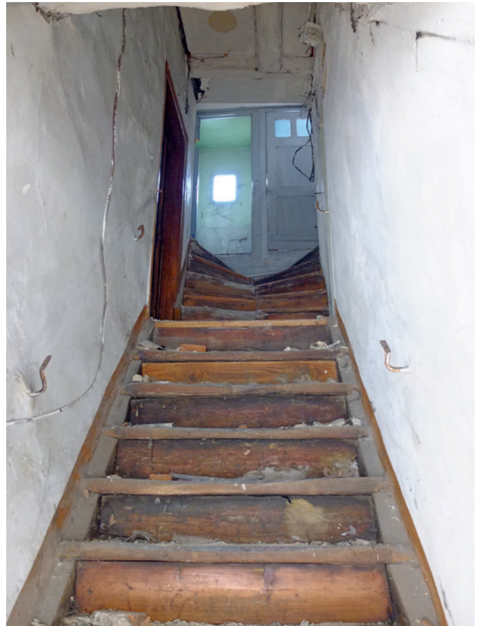
Escalier droit modeste au droit de la porte d'entrée pour desserte d'une maison
