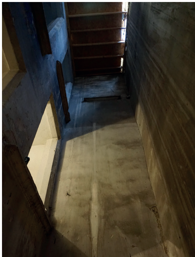
Ancienne courrette pour l'éclairage de la cage d'escalier.
