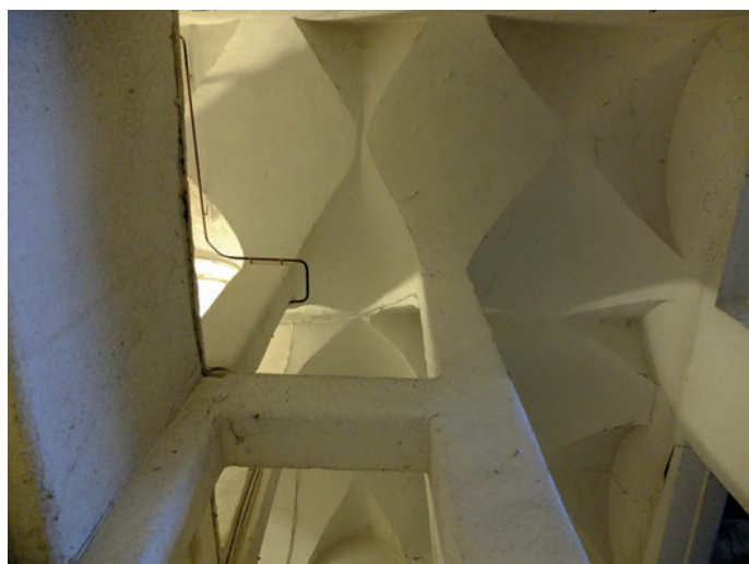
Plafond voûté de l'escalier
