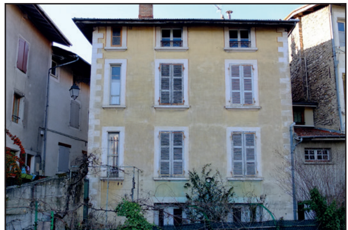
3 passage du Chapeau Rouge - Vue générale
