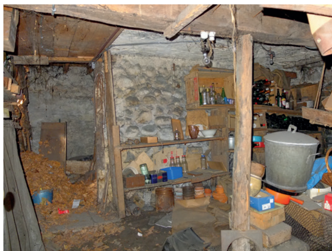
Cave Plancher mixte bois béton modifié au XX e siècle
