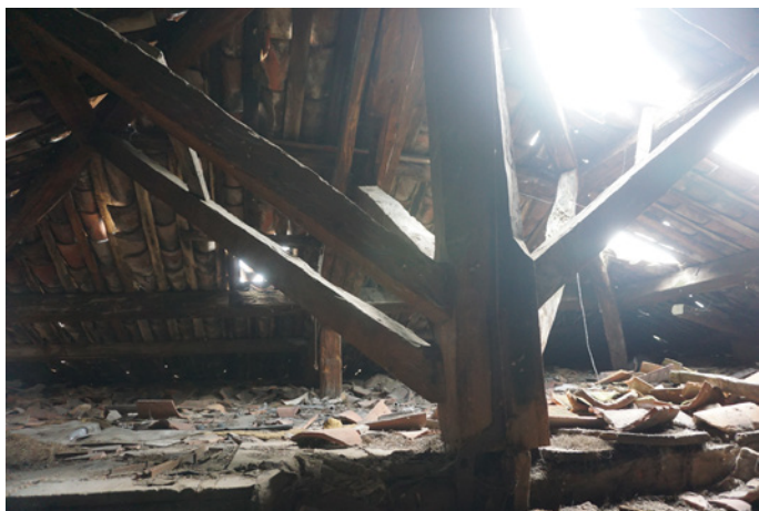
44 Grande Rue - Charpente du comble à poinçon et jambes de forces multidirectionnelles
