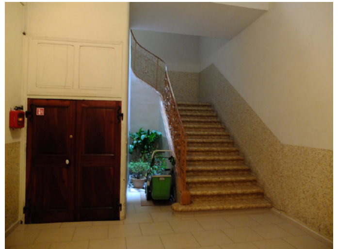
17 place d'Armes - Escalier suspendu à 2 volées et quart tournant, 1 ère volée en pierre et ensuite bois et terre cuite, garde-corps en fer forgé
