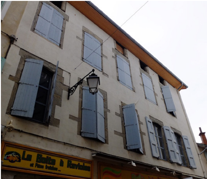
57 Grande Rue - Baies à linteaux délardés
