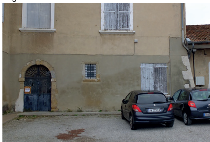
Château - Façade sur cour Porte et encadrement des XVI e -XVII e siècles
