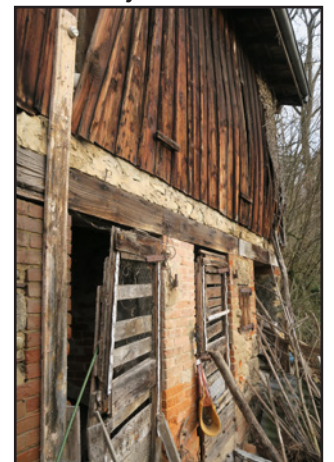
Bâtiment dans jardin
