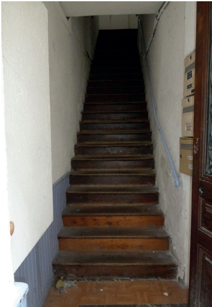
65 Grande Rue - Variante de maison de ville à escalier droit issue de la division du couvent des Carmes
