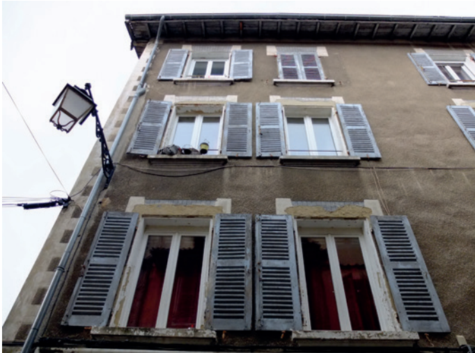
9 rue de France - Trois travées. Fenêtres avec persiennes à lamelles horizontales XIX e ou XX e s.
