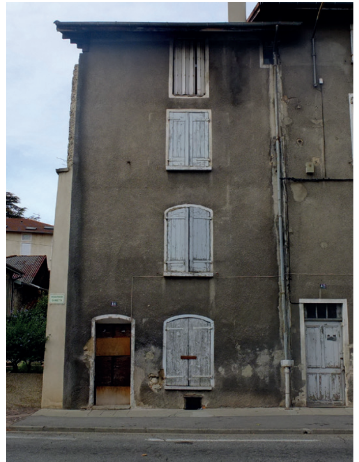
Maison de rempart type de la fin du XVIII e siècle surélevée au XIX e siècle, 44 boulevard Gambetta
