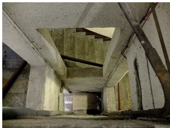
Noyau central évidé de l'escalier
