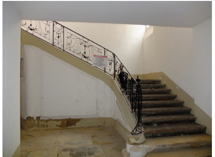
57 Grande Rue - Escalier suspendu à 2 volées et quart tournant, garde-corps en fer forgé
