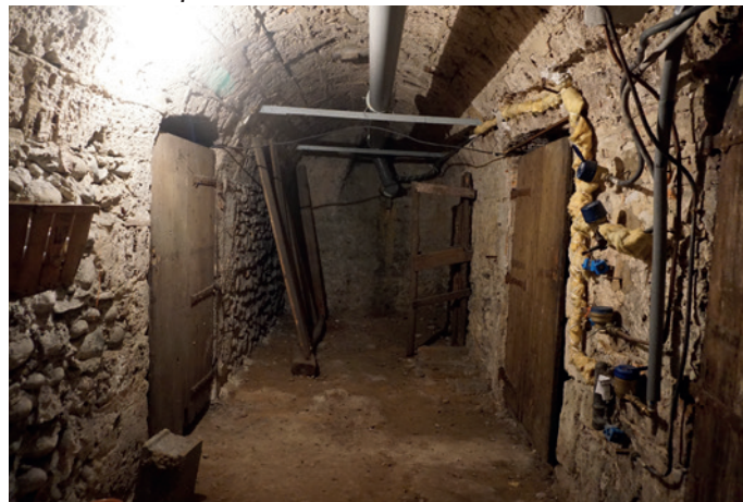
42 Grande Rue - Caves - Murs et voûtes en tuf probablement issus d'un édifice antérieur
