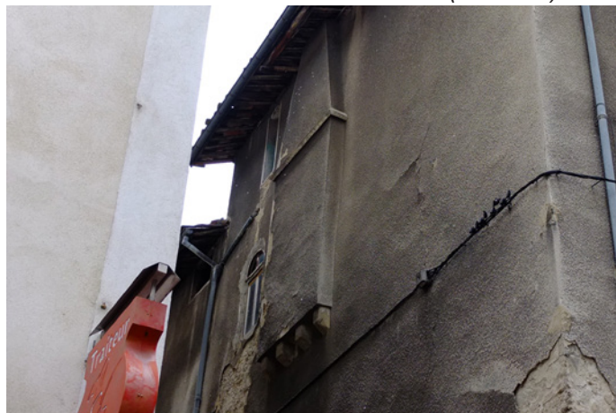
44 Grande Rue - Elévation sur rue de Garagnol Cheminée en saillie au R+2 et fenêtre plein-cintre
