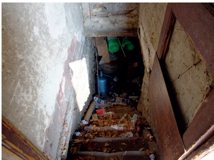
Descente à la cave, escalier pierre, couverture planchers
