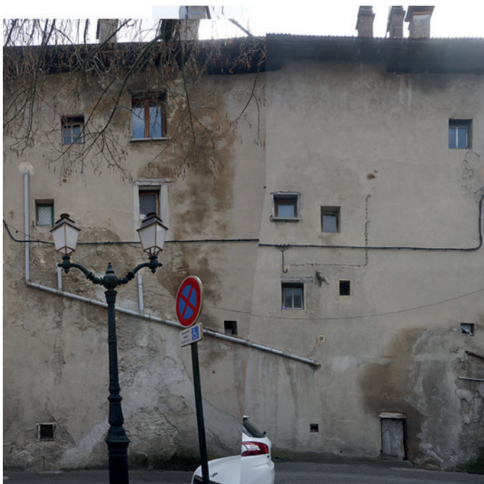
Façade arrière du 34 boulevard Gambetta. Le rez-de-chaussée et le premier niveau, où demeure le rempart, ne sont presque pas percés. Au contraire, les deux niveaux en surélévation sont dotés de nombreuses ouvertures.
