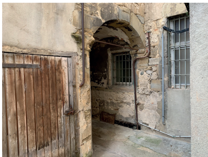
Passage sous porche
