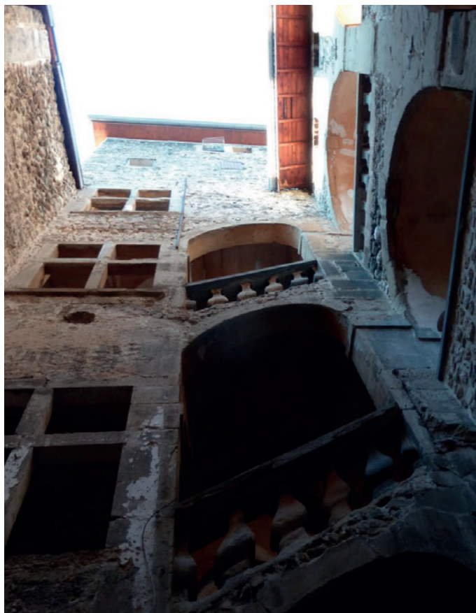
2 rue de Beauvoir - Escalier à deux volées à balustres et paliers à baies à croisées ouverts sur cour
