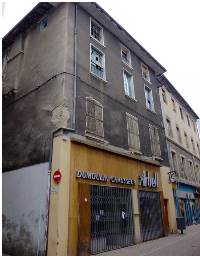
44 Grande Rue - Elévation sur Grande Rue Ouvertures régularisées (XIX e s. ?), enduit ciment
