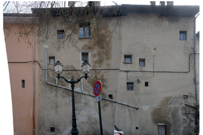
Façade arrière surélevée d'immeuble de rempart, 34 boulevard du Gambetta
