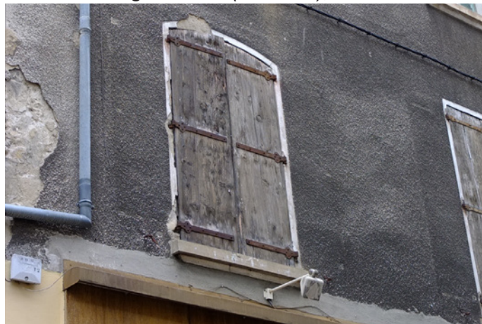
44 Grande Rue - Elévation sur Grande Rue Ouverture ancienne à linteau délardé (XVIII e s.)
