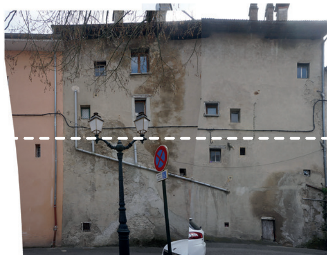
Façade arrière, rempart relativement peu altéré
