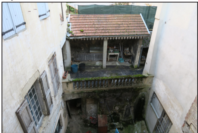
Cour (terrasse au-dessus d'un ancien canal ?)
