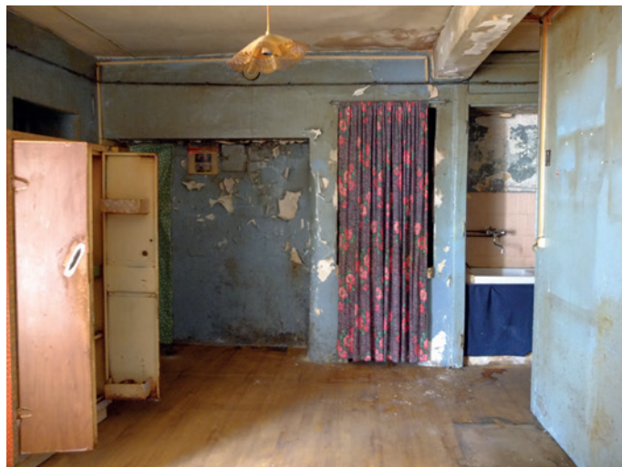
Percement du rempart en fond pour installation de niches et placards muraux divers au rez-de-chaussée
