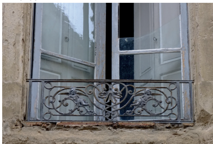
42 Grande Rue - Elévation sur rue Garde-corps et lambrequins fonte
