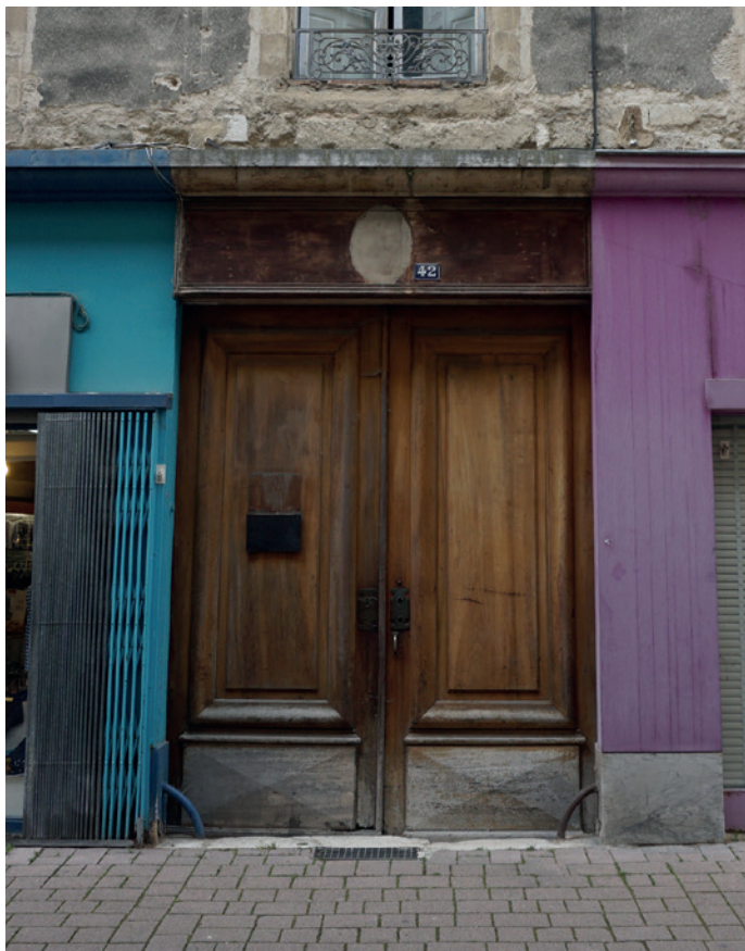
42 Grande Rue - Elévation sur rue Porte noyer
