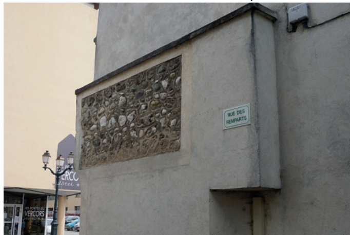
Immeuble de rempart au 16 boulevard Gambetta, mise en scène des vestiges du rempart à l'arrière
