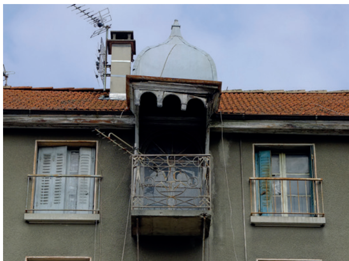
Balcon central du dernier niveau, coiffé d'un toit à l'impériale couvert de zinc, charpente et décors sculptés remarquables, garde-corps en fer forgé comportant les lettres U-V-C-T et des outils de charpentier : équerres, doloires (ou hachettes) et piochons
