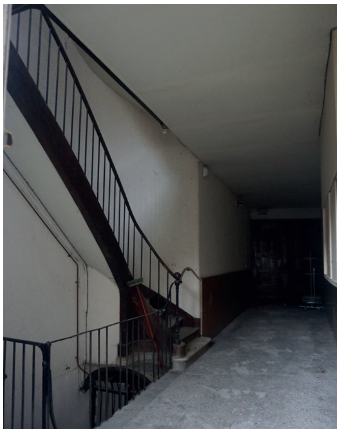
42 Grande Rue - Palier du R+1 Escalier suspendu et porte palière
