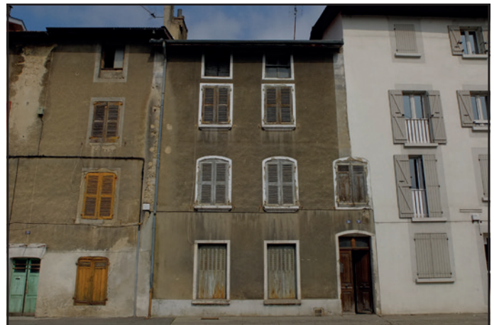
26-28 cours Gambetta, façade sur cours
