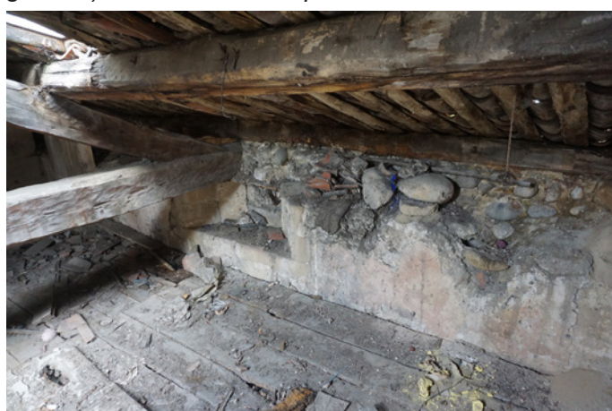
44 Grande Rue - Charpente et comble Anciennes ouvertures, traces d'abaissement du toit
