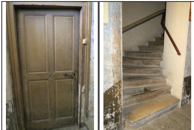
Montée d'escalier du 2 montée du Calvaire
