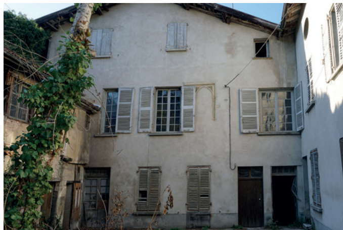
27 Grande Rue - Façade arrière, baies ogivales moulurées murées
