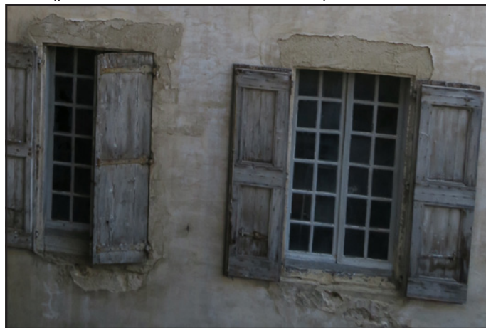
Menuiserie extérieure côté cour
