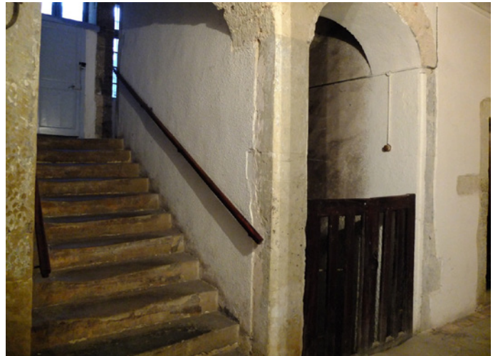
1 passage du Bon Secours - Variante avec escalier droit à 2 volées sur mur d'échiffre, probablement plus ancien
