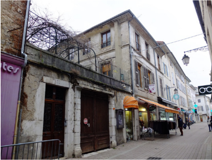
40 Grande Rue - Vue depuis la rue, accès par un porche ajouté au XIX e siècle en remplacement probable d'une grille
