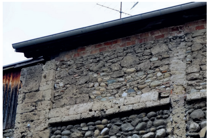
Vestiges d'un larmier en tuf en partie haute du mur d'enceinte témoignant d'un couverture de la courtine
