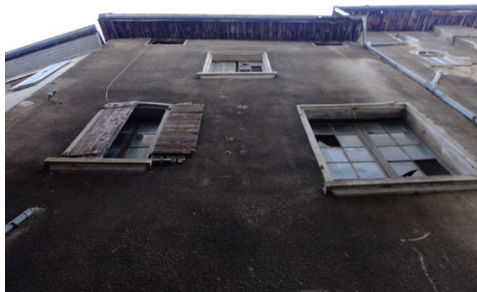
44 Grande Rue - Façade sur rue de Garagnol (partie gauche) - Nombreuses reprises des baies
