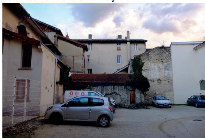
Façade sur cour du couvent des carmes, construction de nombreux édicules en façade
