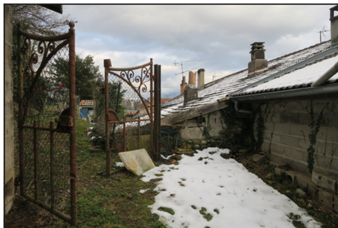
Chemin arrière avec le n°16 à droite (parpaing)
