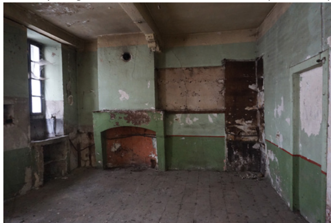
44 Grande Rue - Premier niveau
