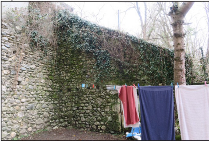
Mur de soutènement dans le jardin
