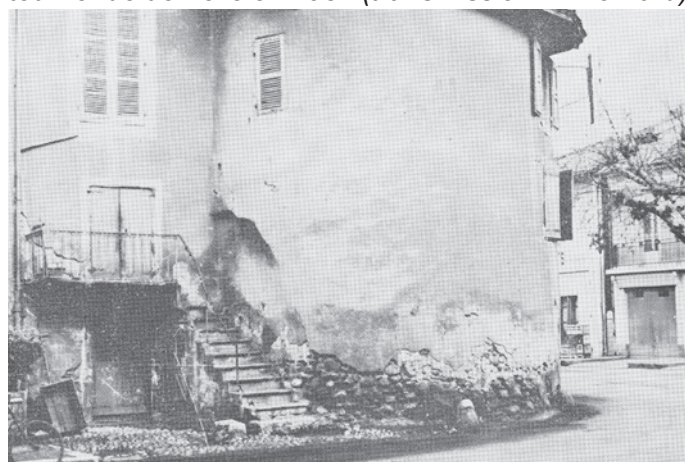
Tour ronde de la place Déagent démolie en 1951 (ouvrage de Jean Sorrel)
