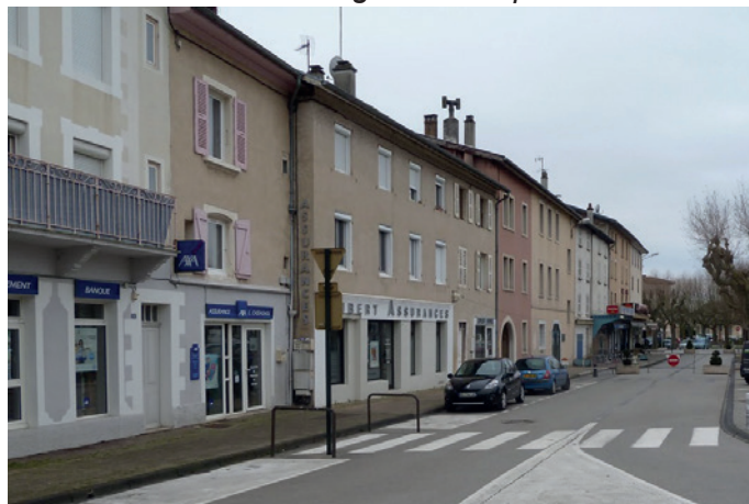
Ensemble d'immeubles de rempart, boulevard du Champ-de-Mars
