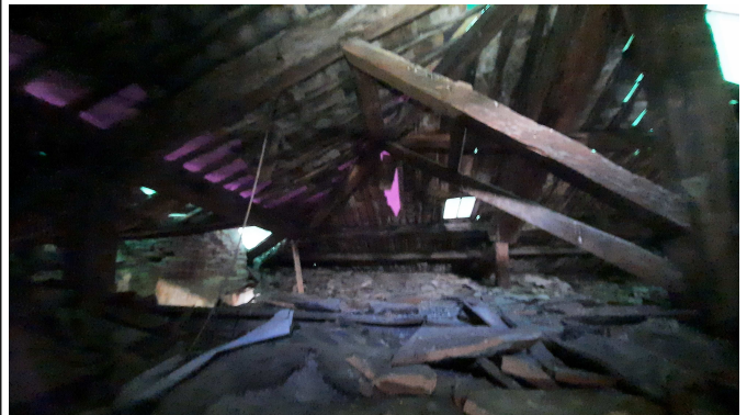
Combles - Point de vue 6
