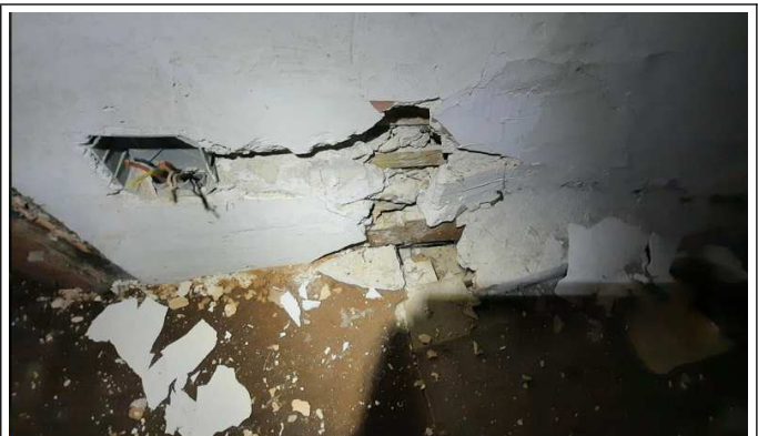
Saigné dans cloison R+1
