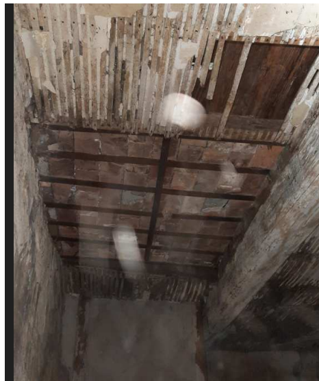
Figure 3: Zone renforcée en métal, avec remplissage en brique de terre cuite.
