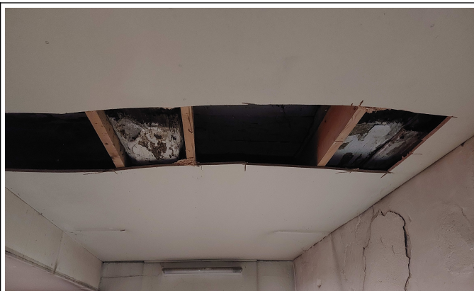
Sondage plafond RDC
