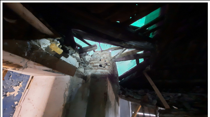
Combles - Point de vue 10
