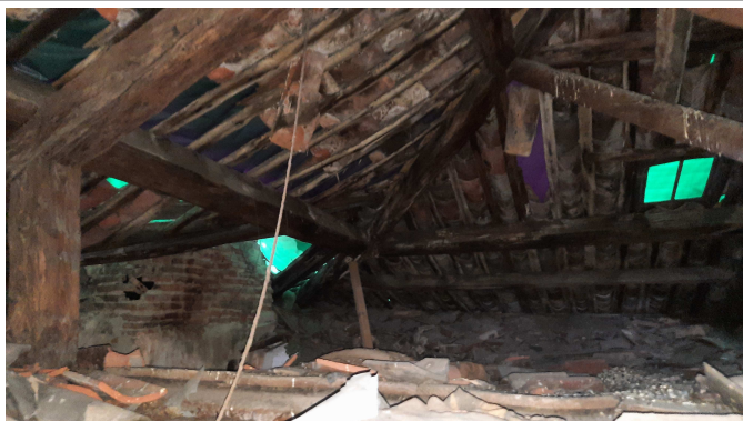
Combles - Point de vue 7
