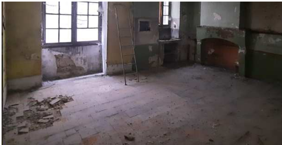
Figure 2: Zone carrelage de type tommette en terre cuite.
