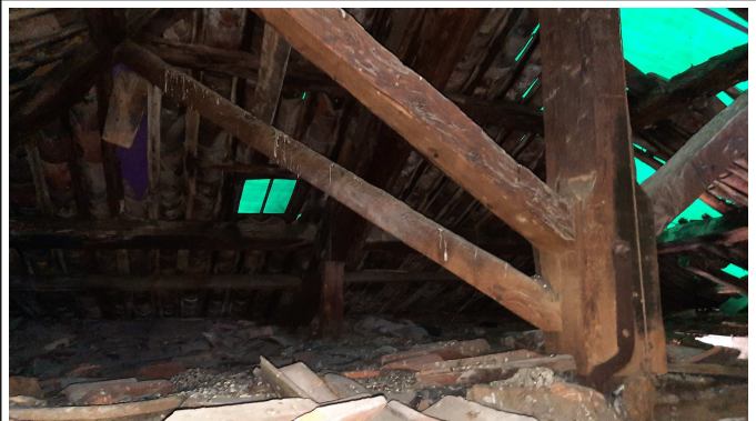
Combles - Point de vue 8
