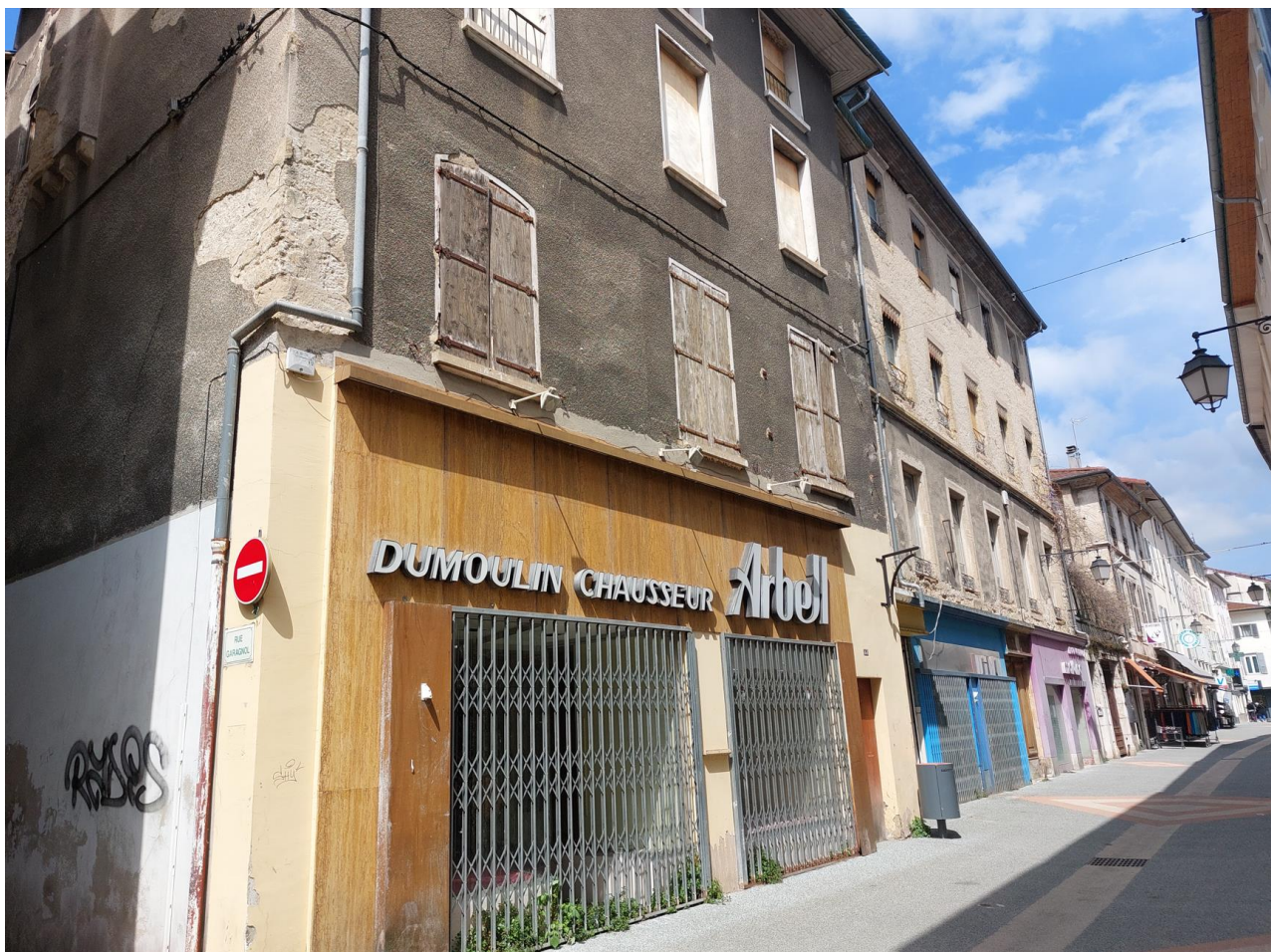
Vue depuis la Grande Rue
