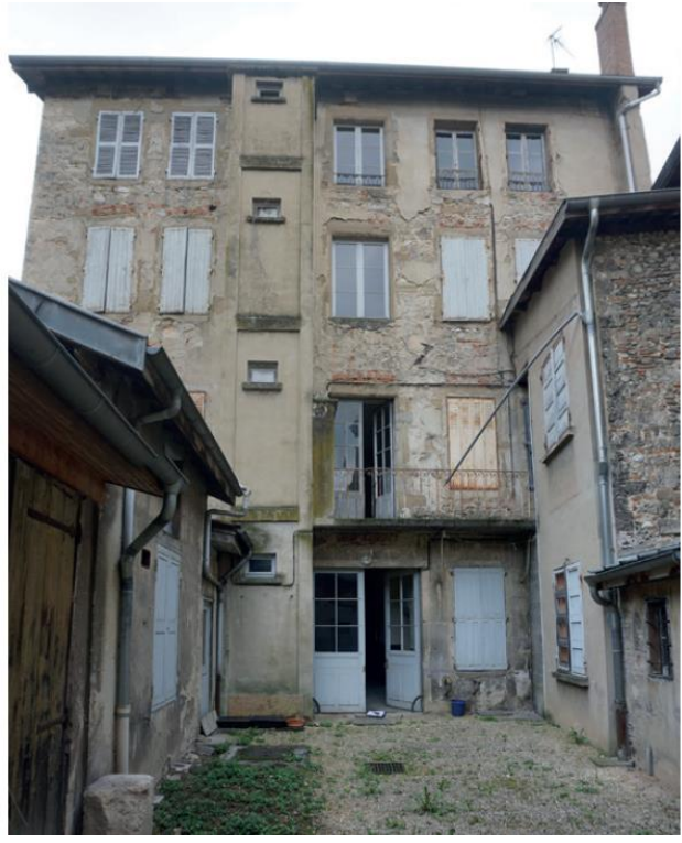
42 Grande Rue - depuis la cour intérieure
