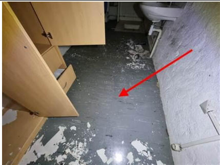
Photo n° PhA003 Localisation : 3ème étage - Salle d'eau Ouvrage : 5 - Planchers et planchers techniques - Revêtements de sols Partie d'ouvrage : Dalle de sol Description : Dalle de sol
