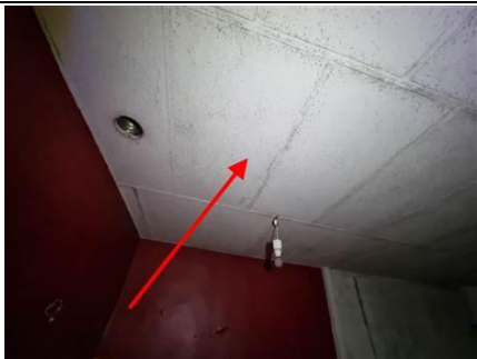
Photo n° PhA005 Localisation : 3ème étage - Bar Ouvrage : 4 - Plafonds et faux plafonds - Faux plafonds Partie d'ouvrage : Panneaux et plaques Description : Matériau souple fibreux de type papier, carton (marron)
