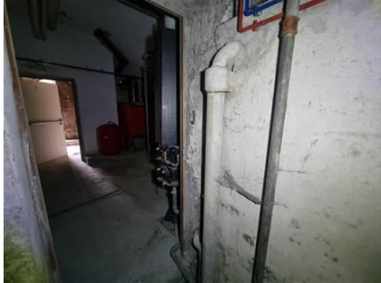
Photo n° PhA007 Localisation : Rez de chaussée - Salle d'eau/WC; Rez de chaussée - Atelier; Rez de chaussée - Local Cuve; 1er étage - Atelier; Batiment OUEST / 1er étage - Plateau; Parties extérieures Ouvrage : 6 - Conduits et accessoires intérieurs - Conduits de fluides (air, eau, vapeur, fumée, échappement, autres fluides) Partie d'ouvrage : Conduit en fibres-ciment Description : Conduit en fibres-ciment
