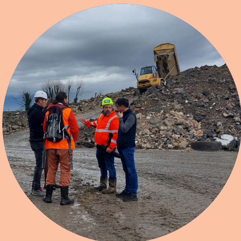
Chantier Paraboot (Tullins) fin de la déconstruction
