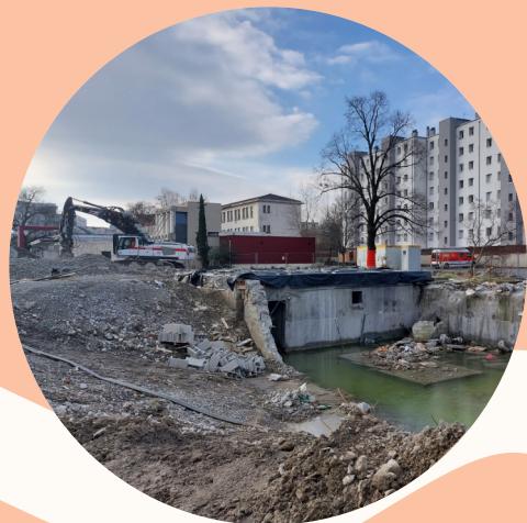
Chantier de l'ex IUFM (Grenoble) Travaux de désamiantage et déconstruction
